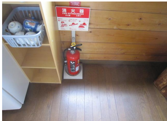
(消火器設置状況)
