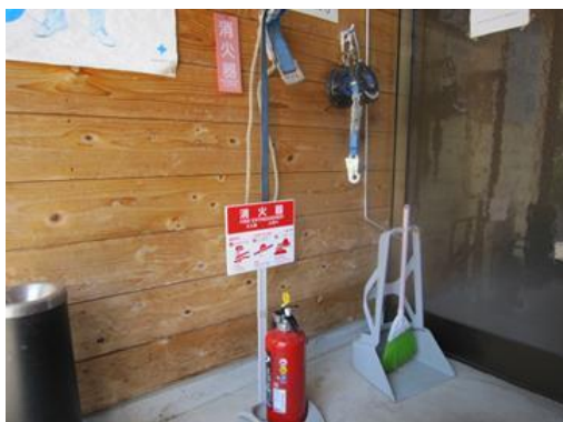
(消火器設置状況)
