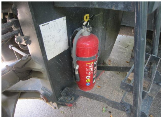
(消火器設置状況)
