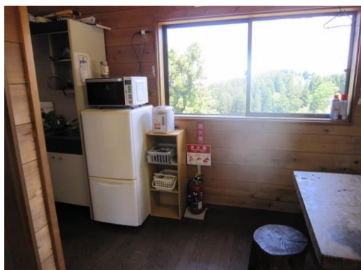
(消火器設置状況)
