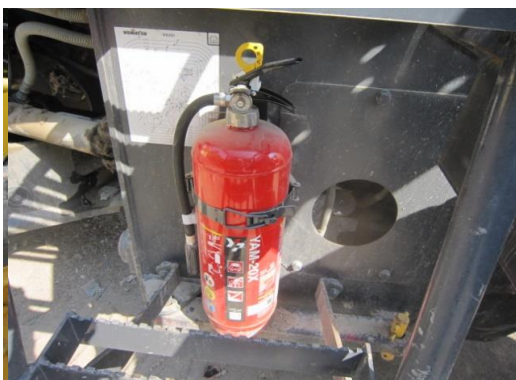
(消火器設置状況)
