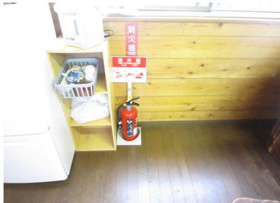
(消火器設置状況)
